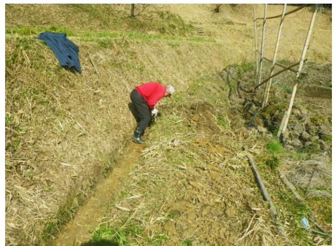
もくもくと側溝の整備
